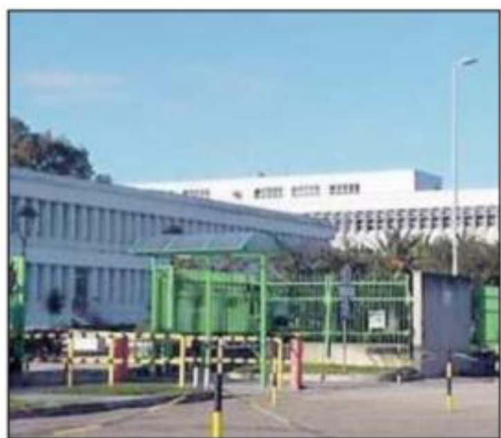
Lo stabilimento di Termoli
